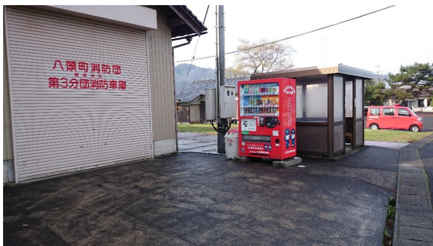
八頭町消防団郡家地区第3分団、船岡地区 消防団車庫
