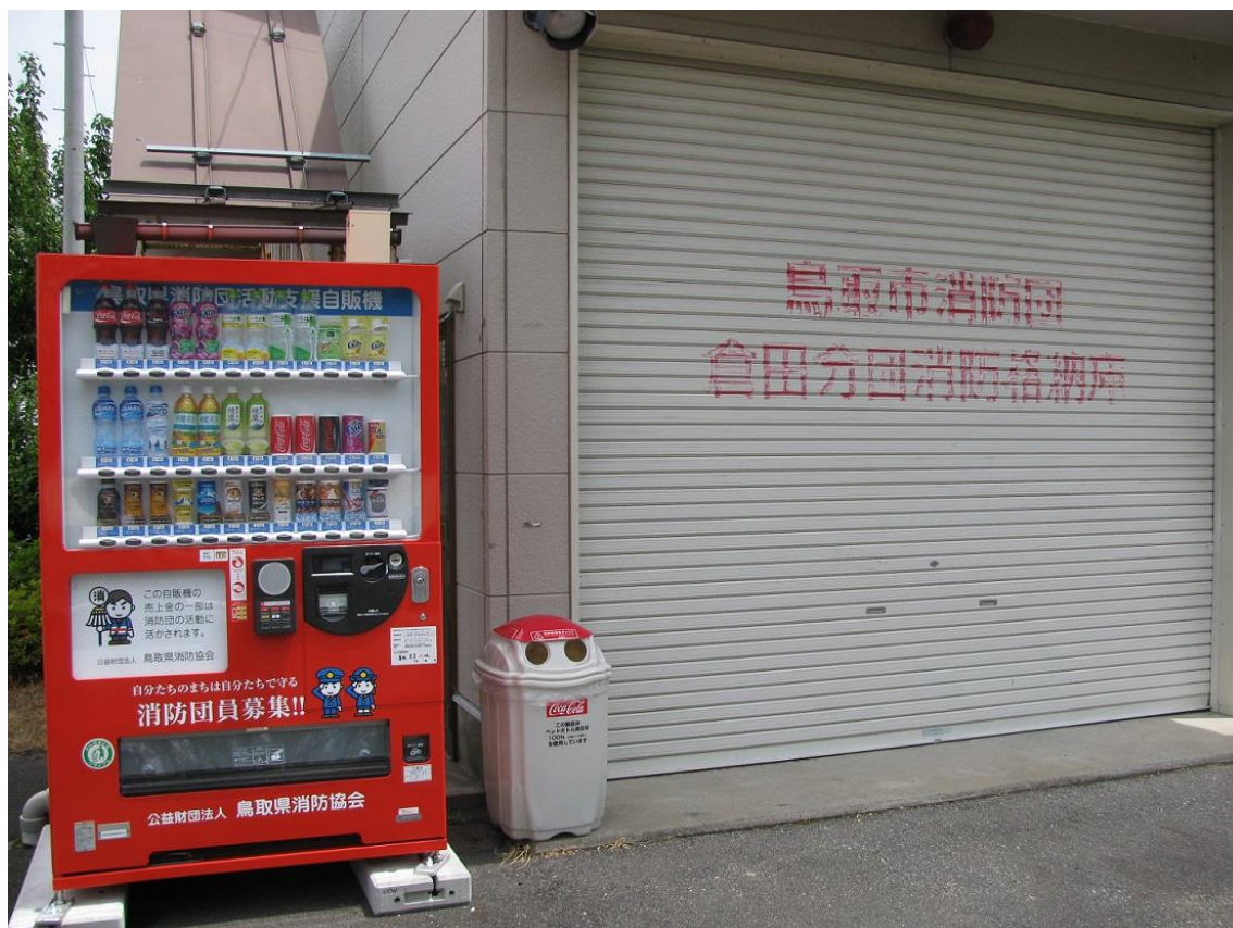
鳥取市消防団倉田分団 消防格納庫
